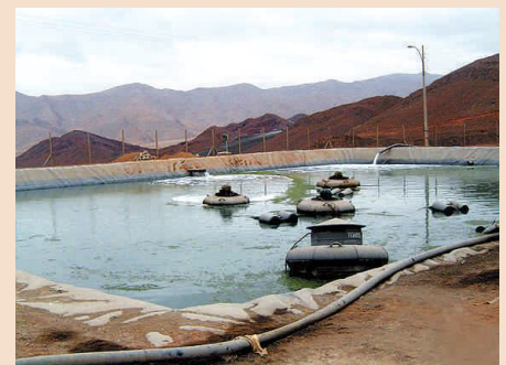
Piscina de recepción de agua de mar.
