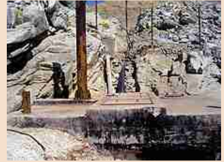
Zona de captación de agua.
