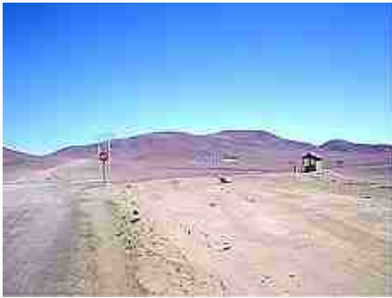
Vista de la subestación eléctrica (en el fondo) y del cruce de la ruta 5 Norte con la ruta B-955 (camino al yacimiento Altamira).
