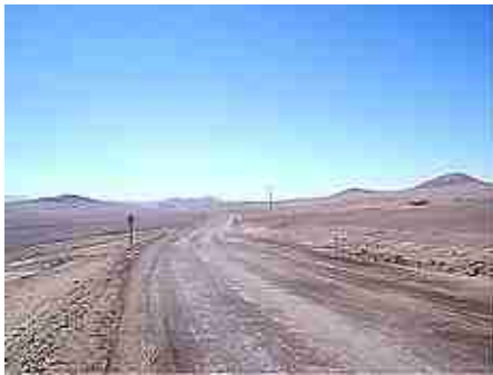
Ruta B-955 hacia el yacimiento Altamira y el nuevo proyecto (vista hacia el Este).
