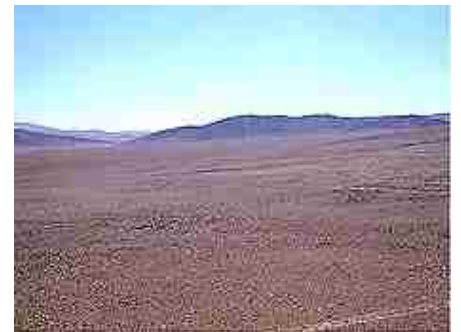
Vista de las líneas de alta tensión y postación eléctrica que hay en el área, ubicadas hacia el noreste del proyecto.
