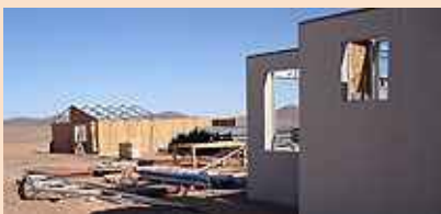
Construcción de oficinas.
