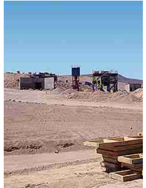
Trabajos en Planta de Óxidos.
