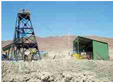
Situación actual del pique de extracción (Peinecillo y galpón huinche).
