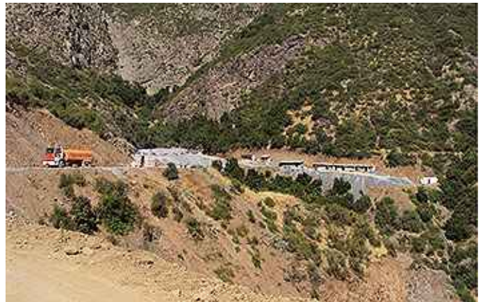
INSTALACIONES DE MINERA LA PATAGUA OFICINA - COMEDOR - DORMITORIOS.
